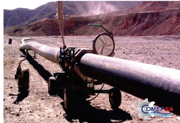
Termofundidora con desplazamiento longitudinal
