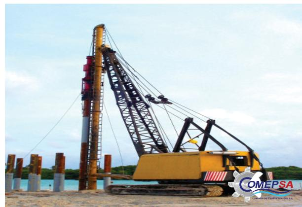
Pala grúa piloteadora de esteras planas con plumas de celosías
